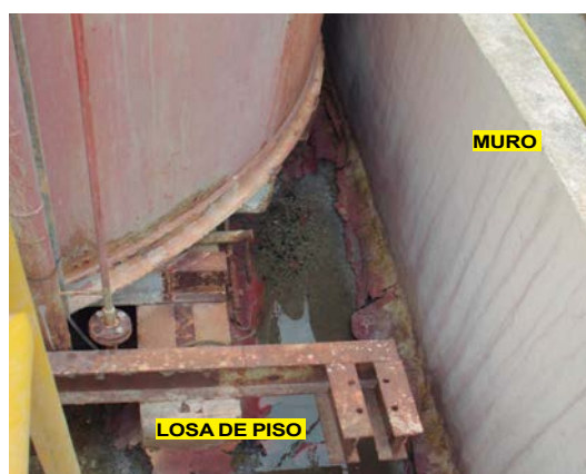
Figura 2 Muros y losa de piso de piscina contenedora
