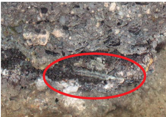
Figura 5 (a) y (b): Pérdida de sección y rotura del acero de refuerzo en base de los muros de contención
