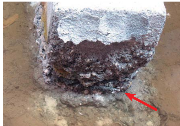
Figura 4 (a) y (b): Acero de refuerzo expuesto en bases de tanques de Ácido Sulfúrico
