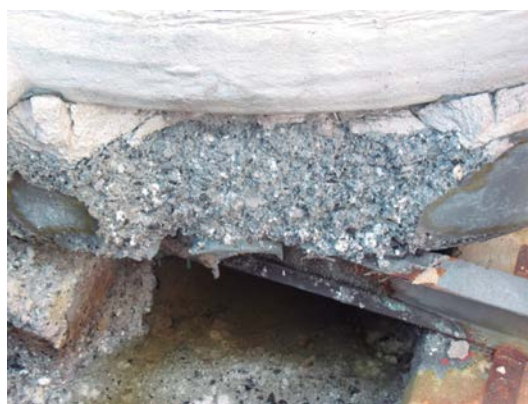
Figura 1 Concreto base de los tanques
