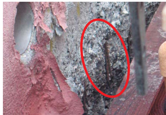
Figura 5 (a) y (b): Pérdida de sección y rotura del acero de refuerzo en base de los muros de contención
