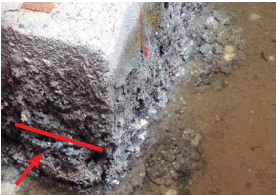
Figura 4 (a) y (b): Acero de refuerzo expuesto en bases de tanques de Ácido Sulfúrico
